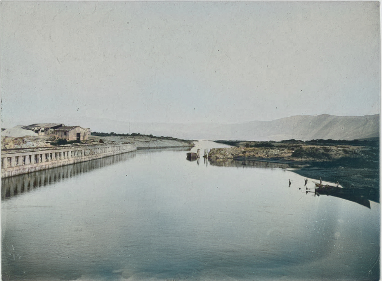
La foto “colorizzata” dei lavori di costruzione del porto di Capoiale. Sullo sfondo, il lago di Varano
